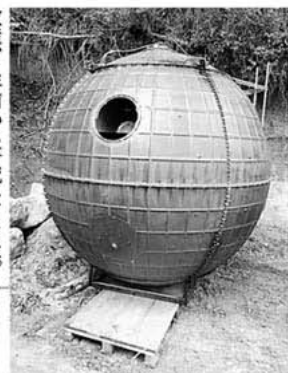
乳牛ふん尿などからバイオガスを生産する発酵槽
