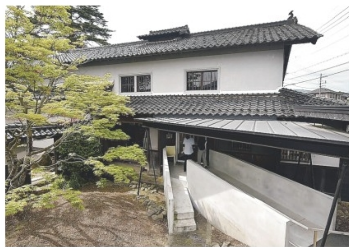
古民家を改修した施設。屋根にはしゃちほこが飾られている
