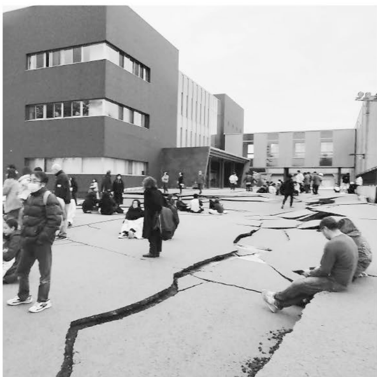
地震で起きたひび割れ＝1日午後4時50分ごろ、石川県輪島市
